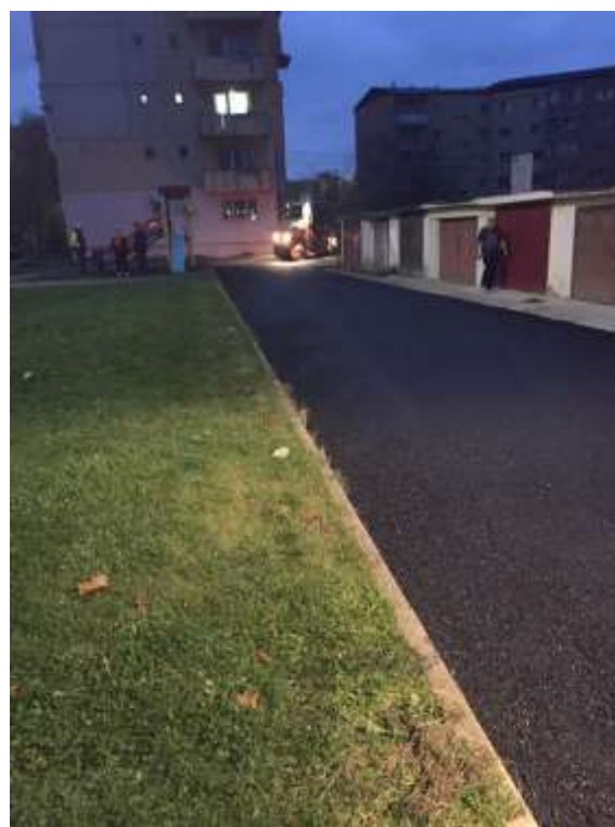
Asfaltare Str. Partizanilor - garaje
