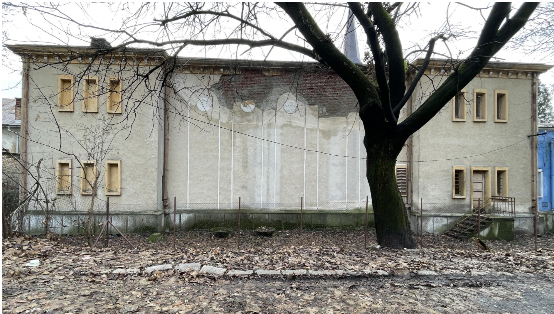
Starea actuală a fațadei nordice
