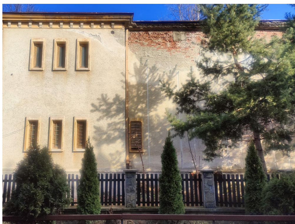
Starea actuală a fațadei sudice
