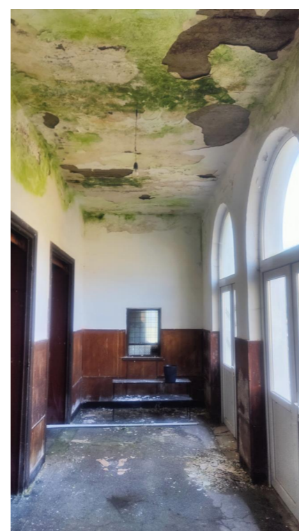
Situația din interiorul holului
